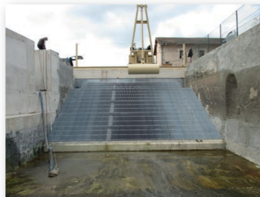
Gitter in 26° im Verhältnis zur Horizontalen mit Auslässen für die Abwanderung
